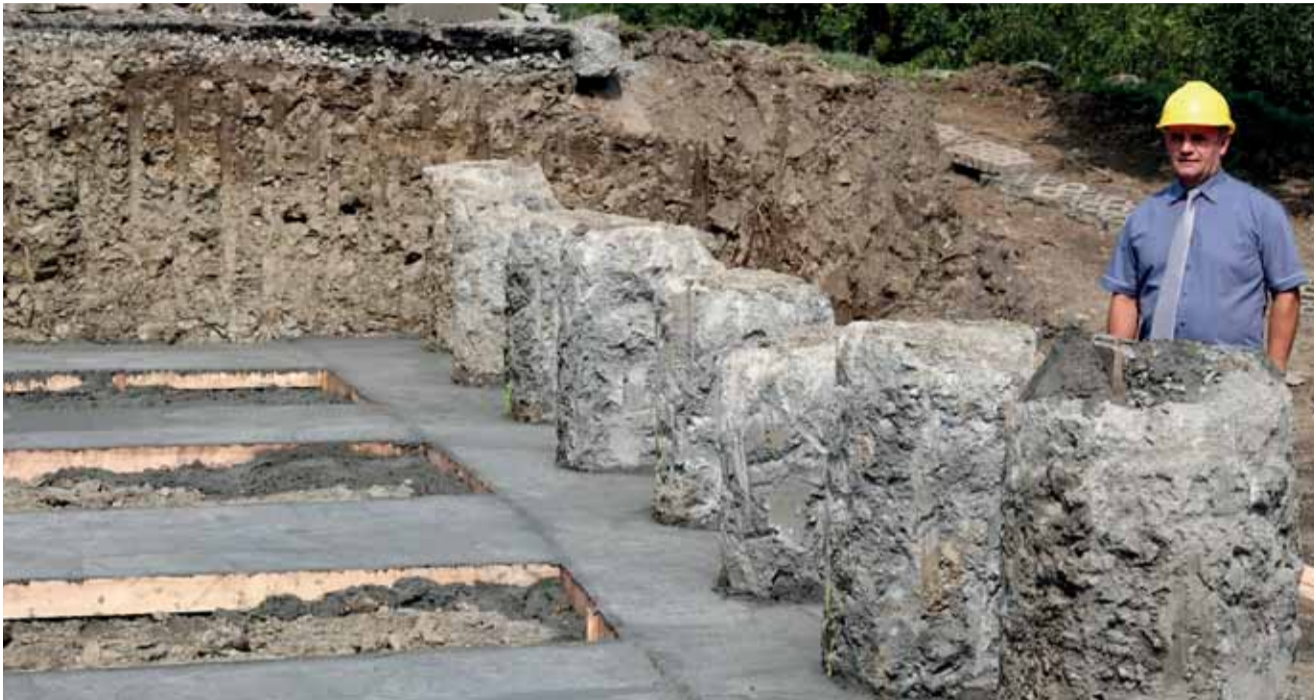
► Wicestarosta Antoni Koszyk sprawdza postęp prac przy stabilizacji osuwiska
