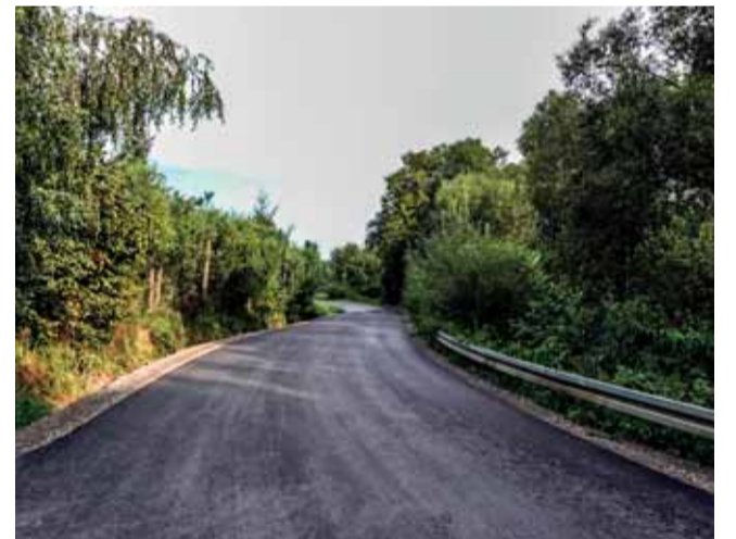
► Jedna z wyremontowanych dróg powiatowych w gminie Korzenna
